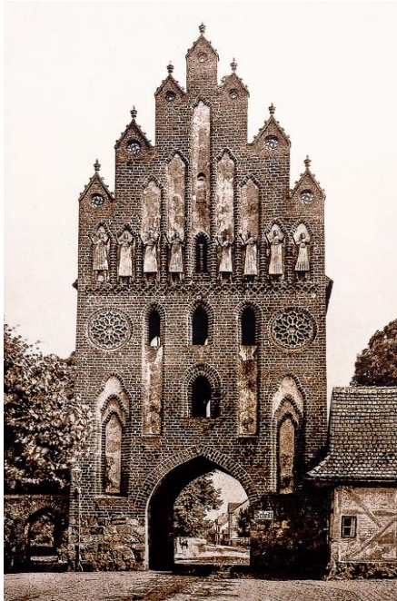
Bild: gotisches Neue Tor in Neubrandenburg, erbaut Ende des 15. Jahrhunderts
